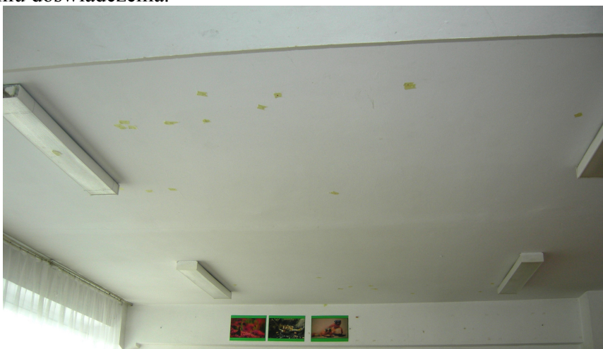
Rys. 1. Zdjęcie sufitu, na którym zaznaczone były punkty pomiarowe
